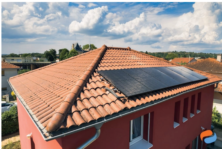
Solarothermie réalisé avec des panneaux hybrides dualsun
